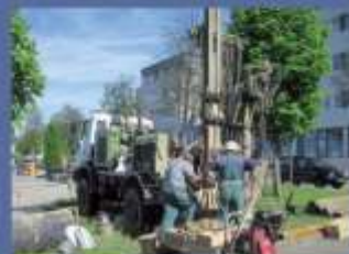
Geotechnische Erkundung bei der ARCUS-Klinik in Pforzheim
