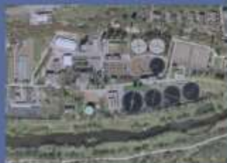
Kläranlage Pforzheim (250.000 E) Erweiterung um nachgeschaltete DN
