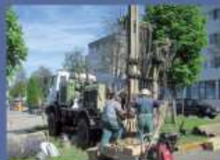
Geotechnische Erkundung bei der ARCUS-Klinik in Pforzheim
