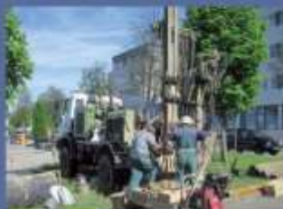
Geotechnische Erkundung bei der ARCUS-Klinik in Pforzheim
