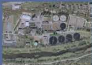
Kläranlage Pforzheim (250.000 E) Erweiterung um nachgeschaltete DN
