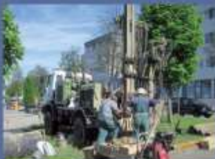
Geotechnische Erkundung bei der ARCUS-Klinik in Pforzheim
