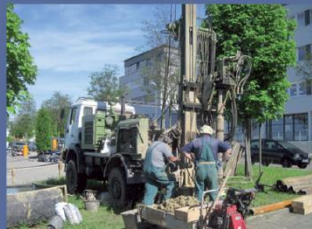
Geotechnische Erkundung bei der ARCUS-Klinik in Pforzheim
