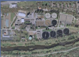
Kläranlage Pforzheim (250.000 E) Erweiterung um nachgeschaltete DN
