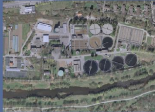
Kläranlage Pforzheim (250.000 E) Erweiterung um nachgeschaltete DN
