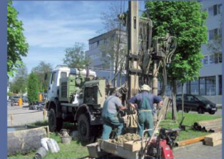
Geotechnische Erkundung bei der ARCUS-Klinik in Pforzheim
