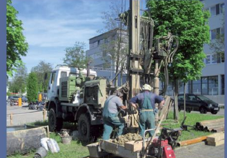
Geotechnische Erkundung bei der ARCUS-Klinik in Pforzheim
