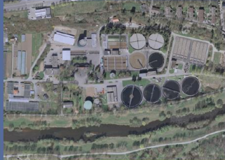
Kläranlage Pforzheim (250.000 E) Erweiterung um nachgeschaltete DN
