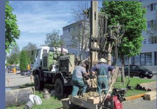
Geotechnische Erkundung bei der ARCUS-Klinik in Pforzheim
