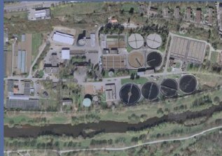
Kläranlage Pforzheim (250.000 E) Erweiterung um nachgeschaltete DN
